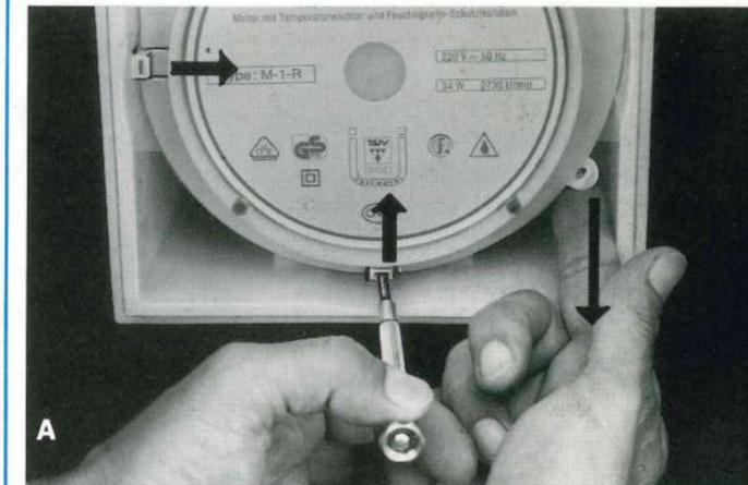
**A.** Abziehen des Ansaugdeckels, Abnehmen der Schalldämmkappe und des Filters. Die Demontage der Abdeckplatte ist aus Sicherheitsgründen nur mit Werkzeug möglich. Mit Hilfe eines Schraubendrehers drücken Sie die Rasternasen nach innen (siehe Bild).
