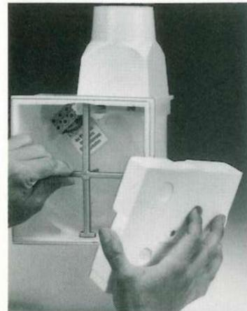
**1.** Styropor-Schutzdeckel und Versteifungskreuz entfernen.
